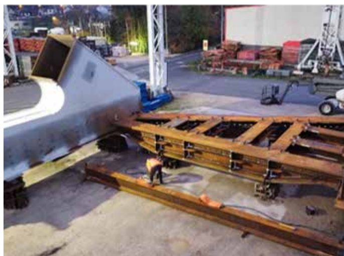
► Montage à blanc sur le parc de BERTHOLD
