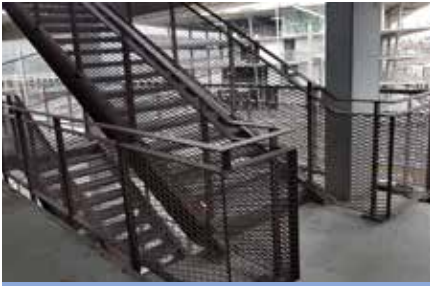
► Garde-corps - Gare de Bordeaux
